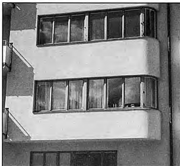
Fönsterparti i burspråk, rundat över hörn.
